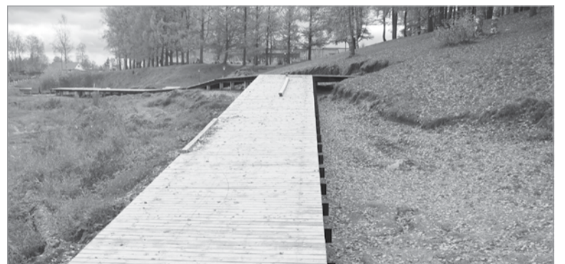
Для настила используют доску сосны
